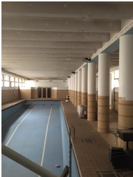
1 er sous sol Piscine
