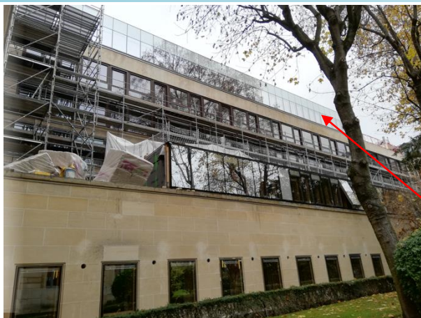
Pose des panneaux de façade
