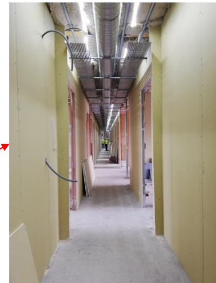
Pose des cloisons, de l'isolation thermique, des bâtis de porte, pose de châssis, pose des chemins de câble et des gaines de ventilation
