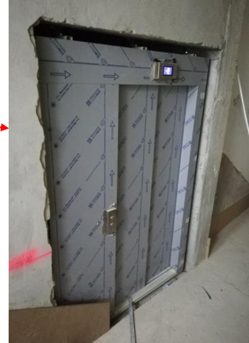
Travaux d'ascenseurs – cage nord en cours de finition
