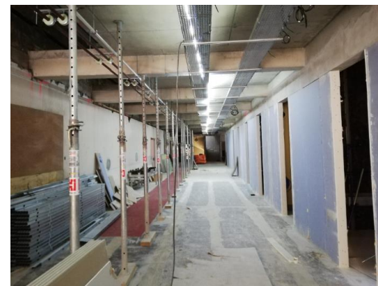
Pose des cloisons de BA13, isolation, gaines, chemins de câbles,...
