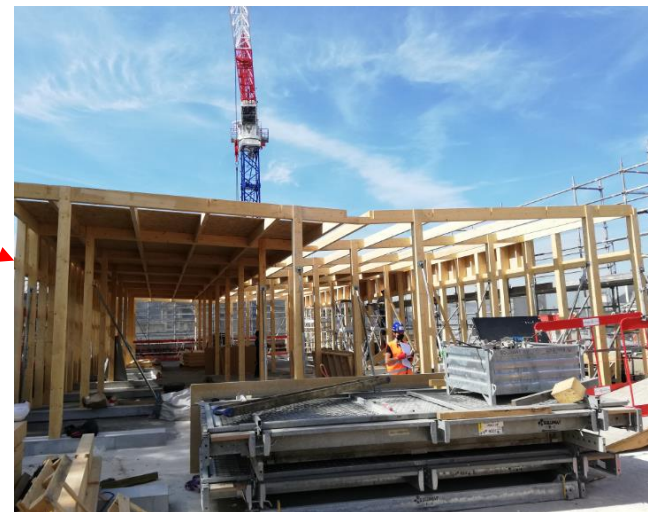
Pose de la structure et de la couverture bois
