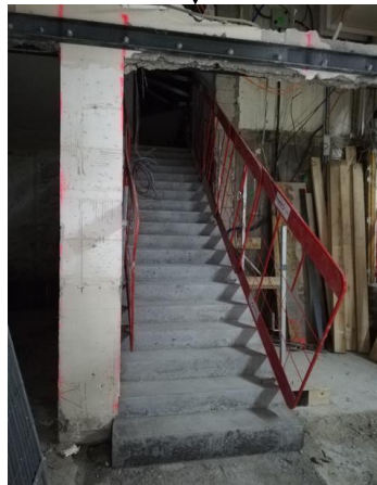
Finition GO de l'escalier Nord - RDC
