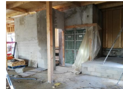
Travaux de l'escalier Nord – R+5
