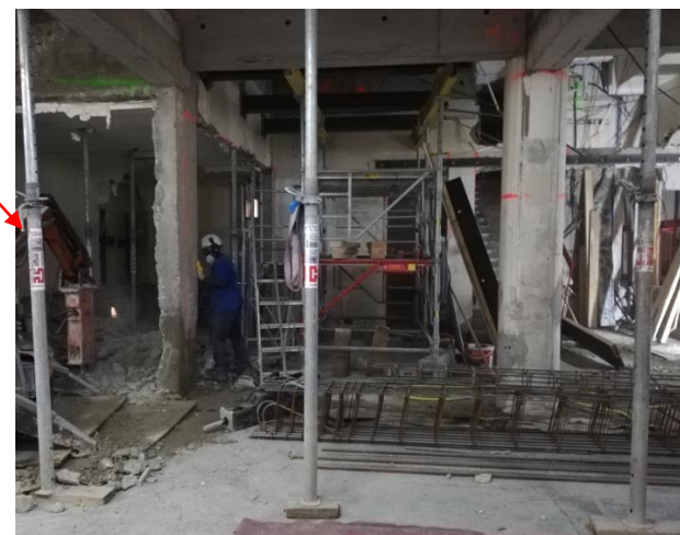
Démolition de l'ancien voile de l'ascenseur Nord
