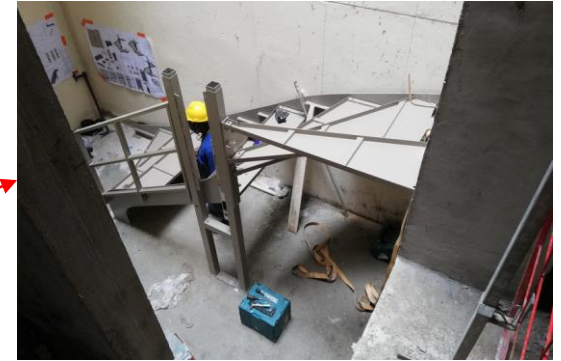
Travaux de l'escalier Nord – R+1
