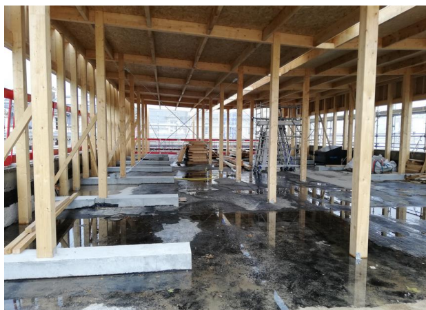
Renforcement de la structure bois : Longrines
