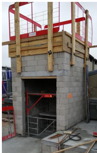
Finition de la construction de la cage d'ascenseur Nord
